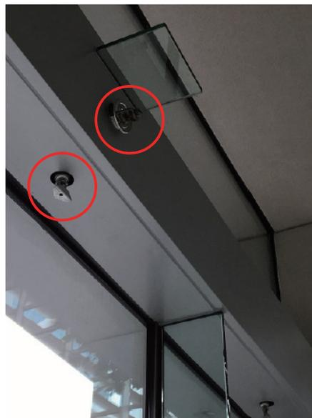
火災時にスプリンクラーからの水をガラス面に当てて、水膜を形成させることによってシステムとして防火性能を担保する。(ガラスのグレードを下げられる・・・)
